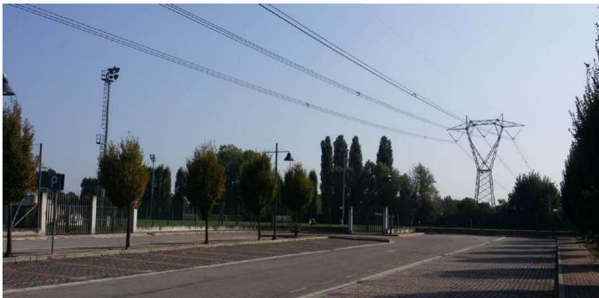
Figura 41 – l'elettrodotto che attraversa Viale dello Sport
